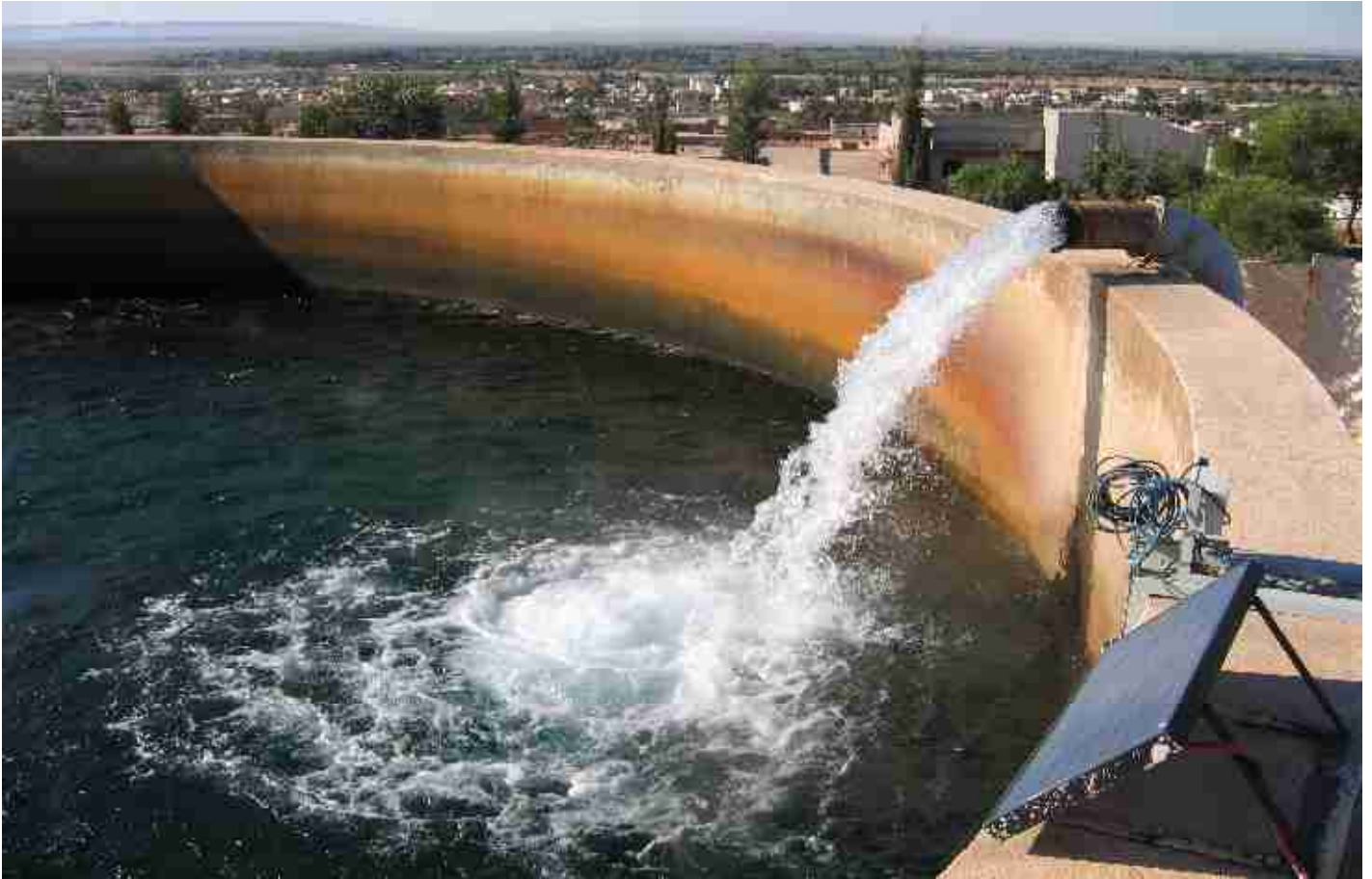
PHOTO 1 : BASSIN DE 2500m 3 R1 DU RESEAU COMMUN A RAGOUBA
