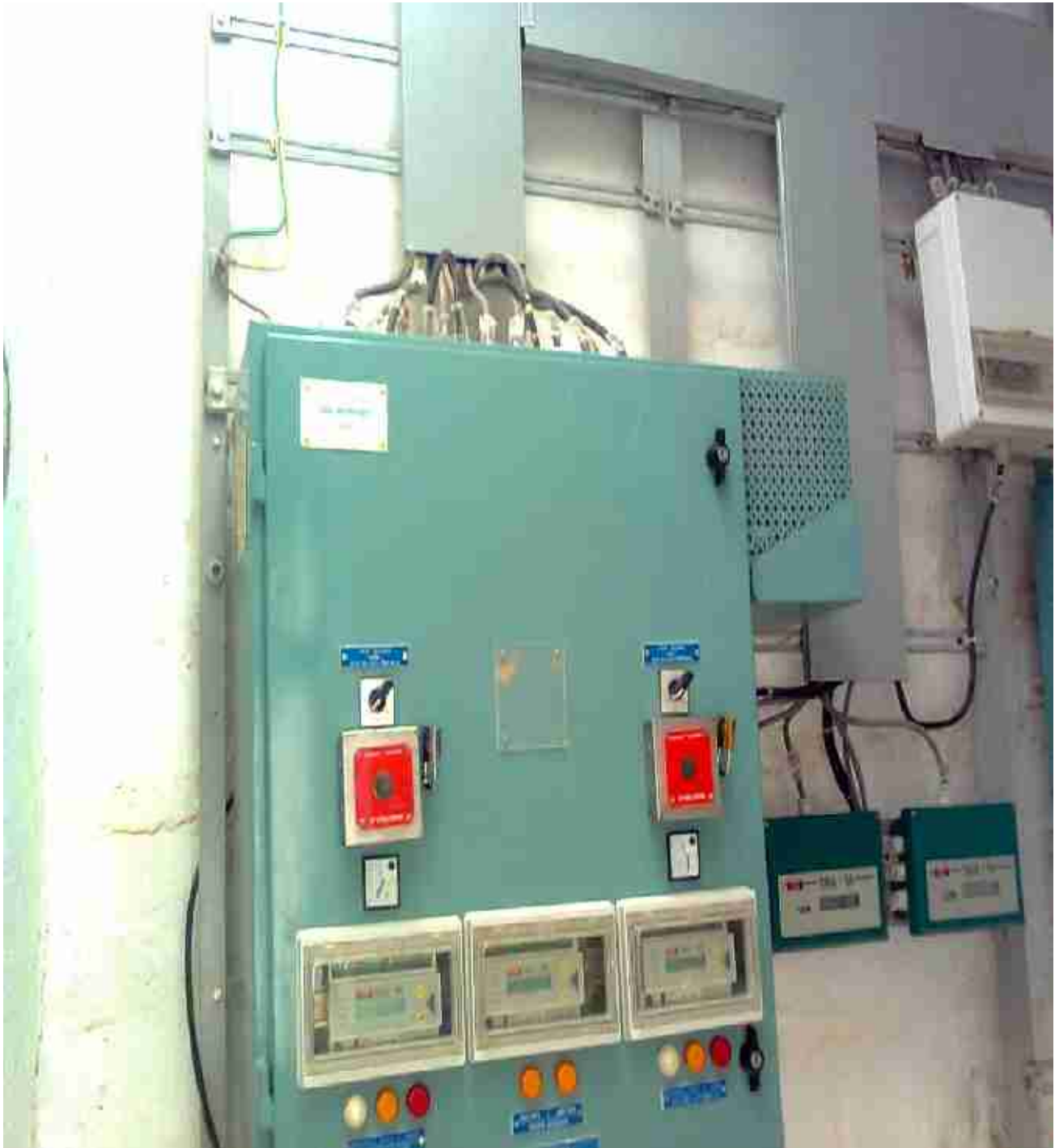
PHOTO 4 : ARMOIRE DE COMMANDE DES VANNES MOTORISEES AU R1
